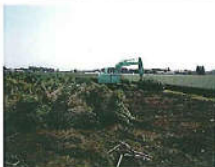
再生整備(茶木の引抜作業) この後トラクターで細かく破砕しました
