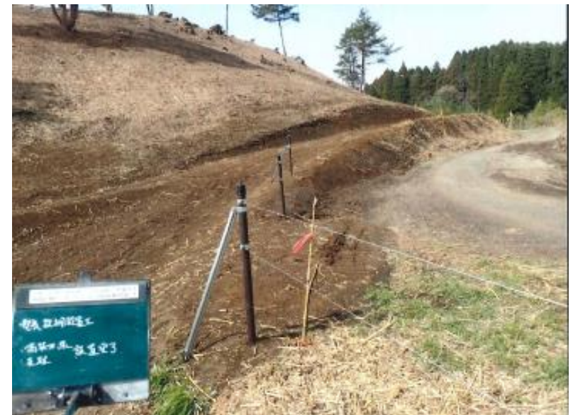
電気牧柵設置
