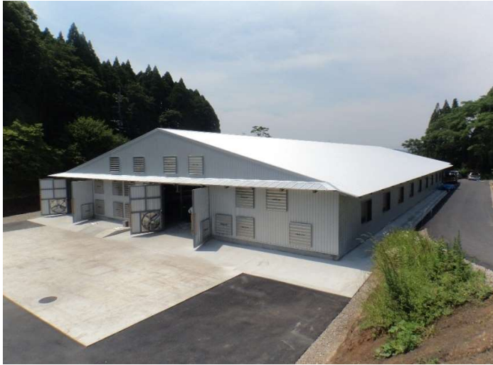
乳牛舎鉄骨造（全 景）
