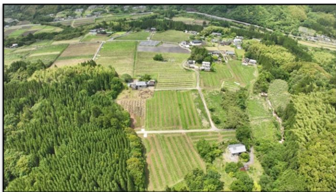
深谷地区整備完了 全景
