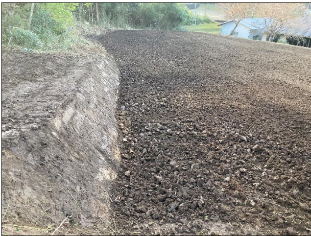
【草地造成工事】
