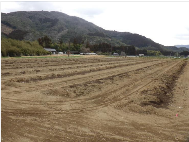
【排水改良工事】
